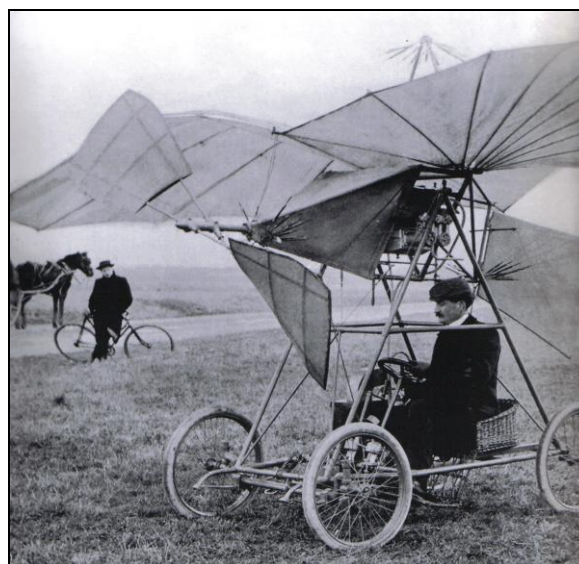
Fig. 5. Aeroplanul Automobil Vuia nr.I experimentat în zbor la 18 martie 1906 pe terenul de la Montesson de lângă Paris. Elicea bipală de tip Tatin cu diametrul de 2,2 m și pasul constant de 2,4 m era plasată în axa avionului și avea turația de 450 rot/min pe o durată de maxim 5 minute cât era acționată de motorul realizat de Traian Vuia.
