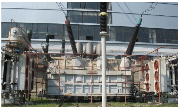
Fig. 2. Ansamblu transformator - echipament de monitorizare.
