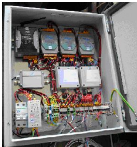
Fig. 9. Echipament de monitorizare a stării posturilor de transformare. Varianta 1.
