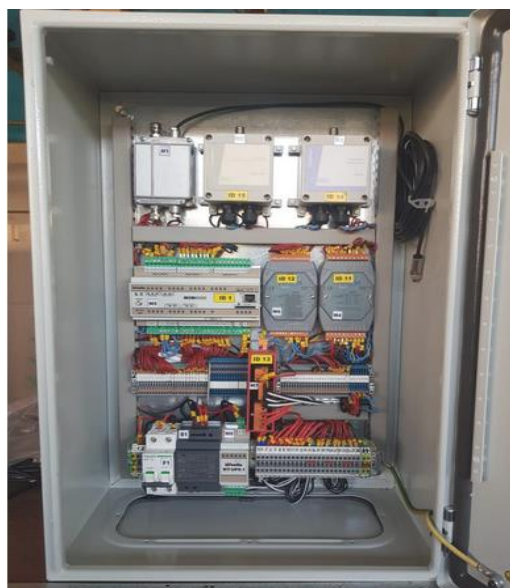
Fig. 11. Echipament de monitorizare a stării posturilor de transformare. Varianta 2.
