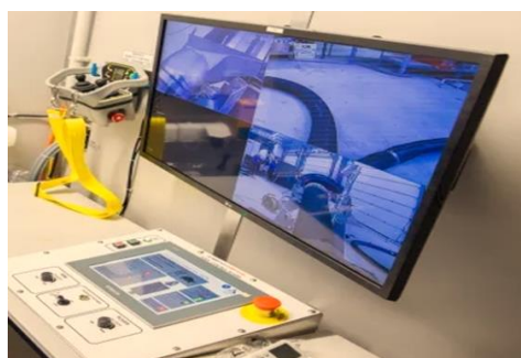
Fig. 5.4. Execuție și monitorizare proces de curățare (imagine foto).
