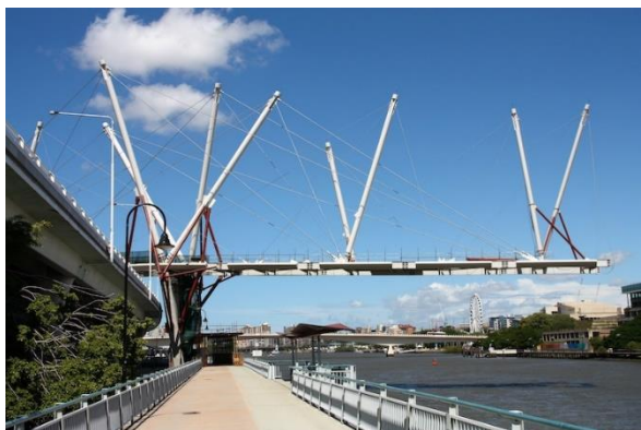
Fig. 2. Aplicarea conceptului Tensegrity în arhitectură și inginerie – Kurlipa Bridge (My Modern Met - Pires 2021 - https://mymodernmet.com/tensegrity-architecture/ )
