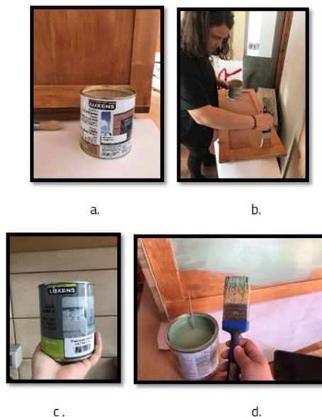
Fig. 3.17. Aplicarea finisajului opac (a – tipul de grund folosit, b – aplicarea grundului prin pensulare, c – tipul de vopsea folosită, d – aplicarea vopselei prin pensulare).
