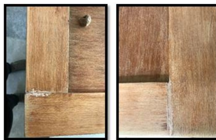
Fig. 3.10. Exemplu de chituire pentru acoperirea găurilor.
