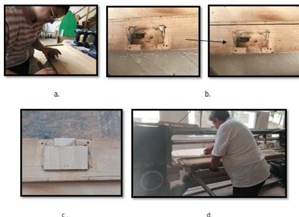
Fig. 3.11. Etapele de înlocuire a sistemului de închidere cu cheie (a- eliminarea broștei din metal, b-pregătirea suportului prin dăltuire, c- umplerea găurii, d- șlefuirea excesului de material)
