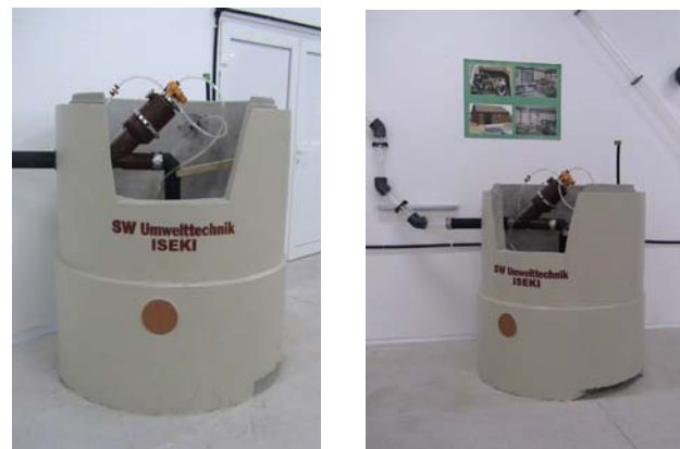
Fig. 2. Cămine colectoare de ape uzate menajere.
