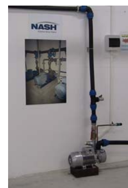
Fig. 6. Pompa de vacuum.
